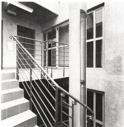
Escalier bâtiment neuf
