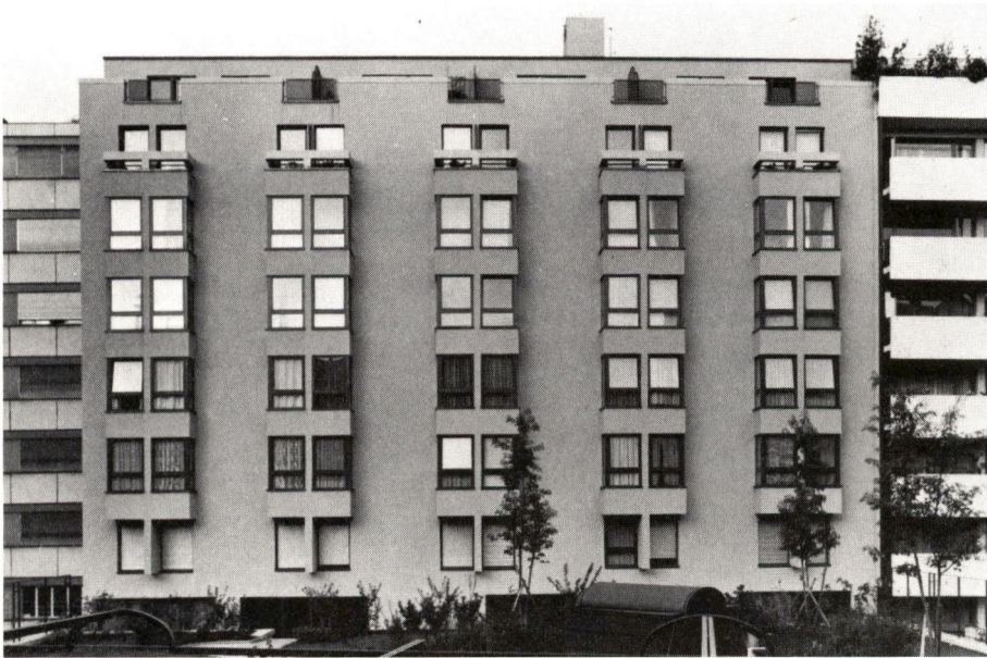
Façade cour immeuble rue Dancet
