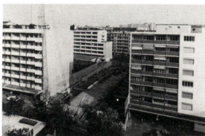
Chantier rue Dancet
