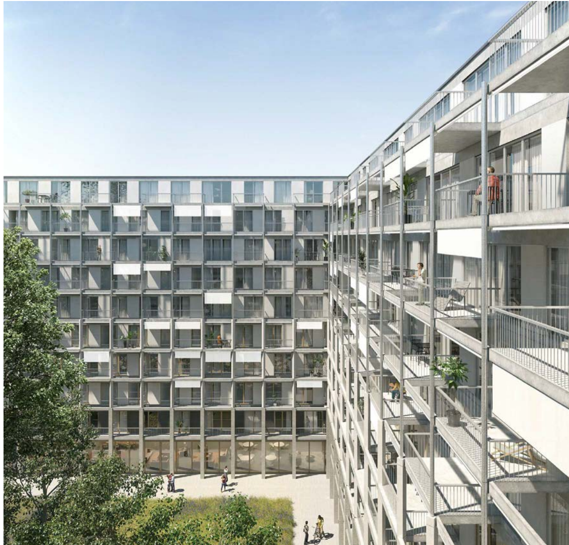
Ilôt B vue cour intérieure
