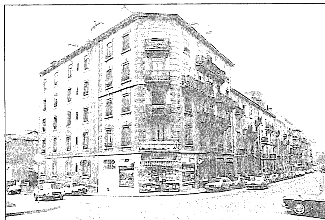
Boulevard du Pont-d'Arve 11 à 19
