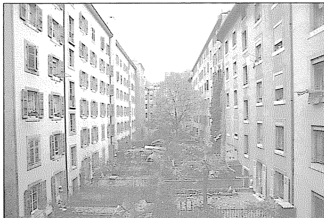
L'intérieur de l'îlot
