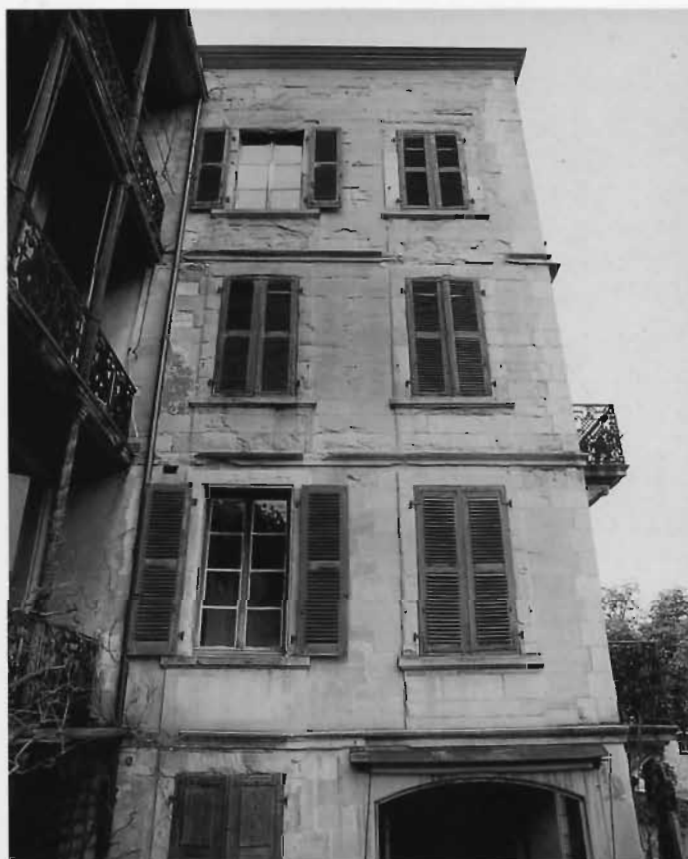
Façade de l'hôtel sur la Treille, état de la molasse très dégradée de la tourelle, avant restauration
