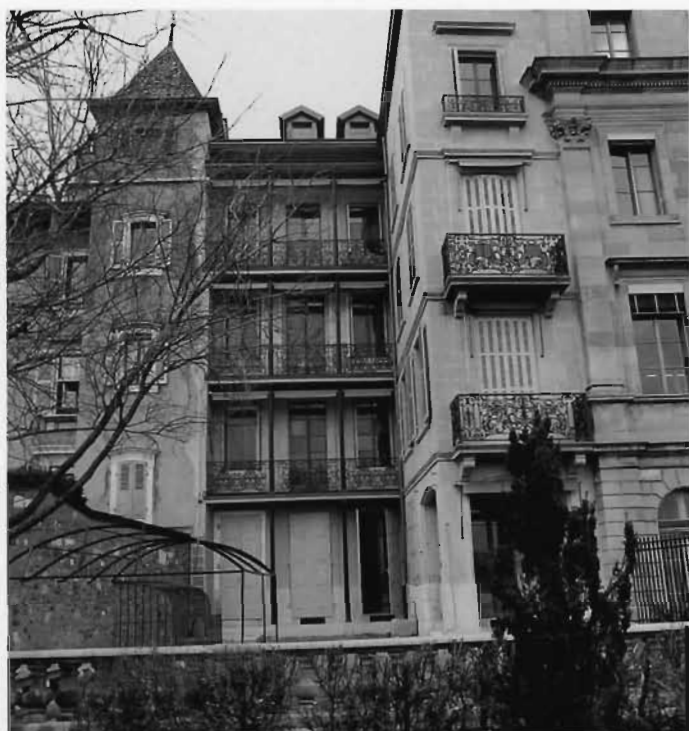
Façade de l'hôtel donnant sur la Treille, vue après restauration
