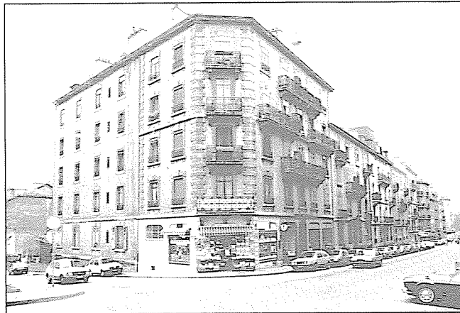
Boulevard du Pont-d'Arve 11 à 19
