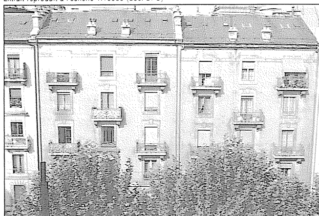
Rue du 31-Décembre 58 et 60
