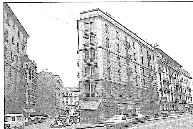
A gauche, la rue de la Puiserande; à droite, la rue des Deux-Ponts côté impair
