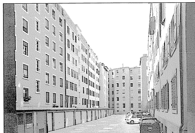
Rue Cingria, rue Prévost-Martin; l'intérieur de l'îlot
