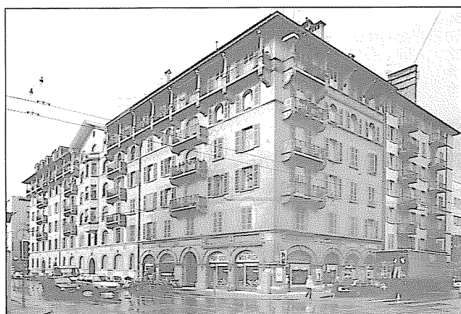
Angle rue de l'Ecole-de-Médecine, boulevard Carl-Vogt
