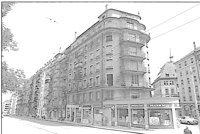
Rue de Lyon 23 à 33
