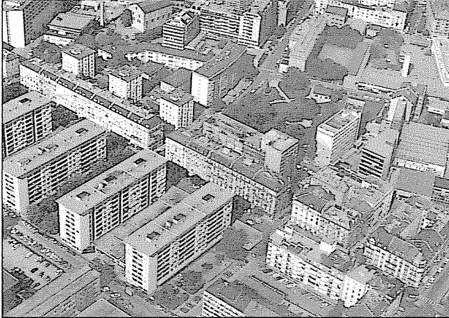
Le boulevard Carl-Vogt, de l'avenue de Sainte-Clotilde à la rue des Bains
