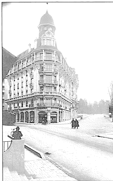
Avenue Théodore-Weber, vue ancienne (photo VG)
