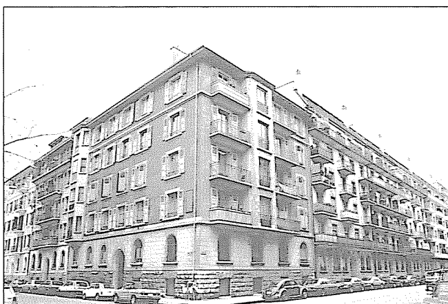
Rue Frédéric-Amiel 1 à 5, rue Camille-Cavour 12, 10, 8
